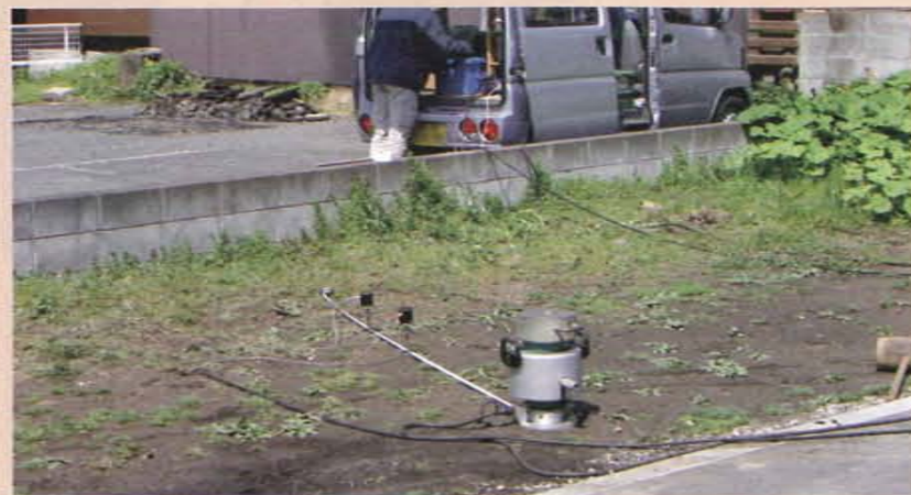
起振機(中央手前)と2つのセンサー(その奥)を遠隔操作し、車内に積んだパソコンでデータをチェックしている様子。アキュラホーム建築企画部建築開発課課長の細貝憲一さんは、表面波を標準にしている理由について「SSと違い、地中に堅い障害物があっても測定できる点がいい」と話す
